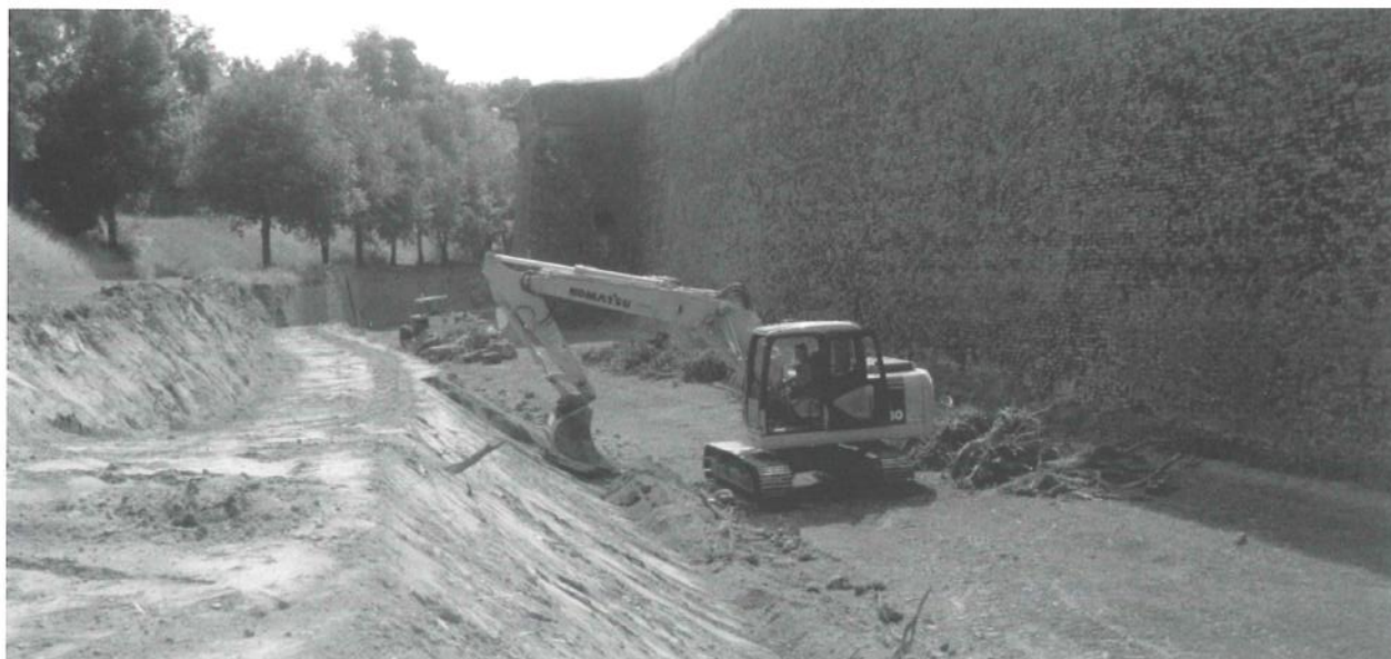
Sistemazione del fossato Rivellino
