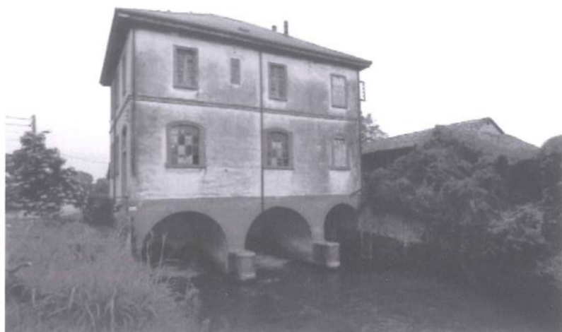
La Centrale idroelettrica di Mirabello
